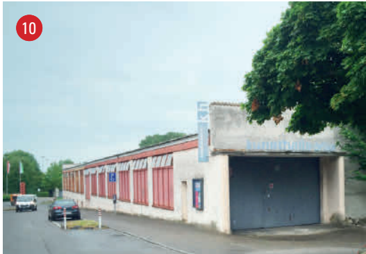
Grabenstrasse 6 Kunsthalle Arbon
